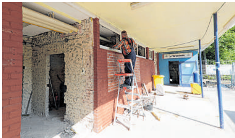
An den Umkleiden und dem Vereinsheim am Sportplatz an der Meisenburgstraße wird noch gearbeitet.
